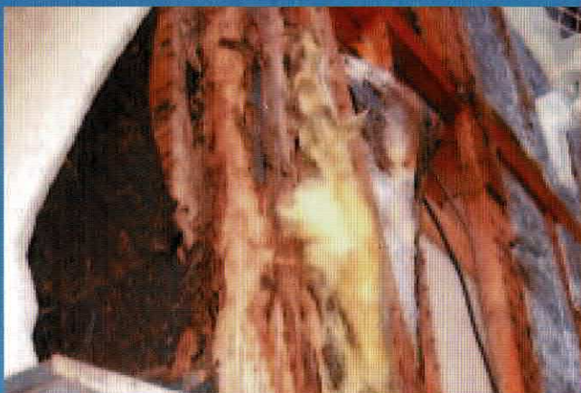
完全に腐朽し、塗装によるリフォームができなくなっていた。
