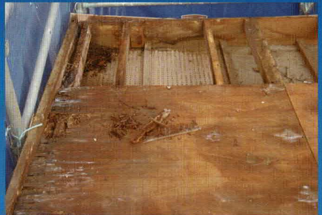
下地材が腐朽している。
