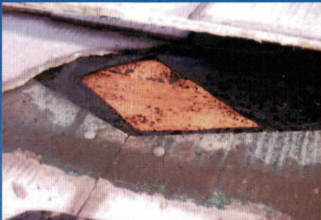
完全に腐朽し、塗装によるリフォームができなくなっていた。
