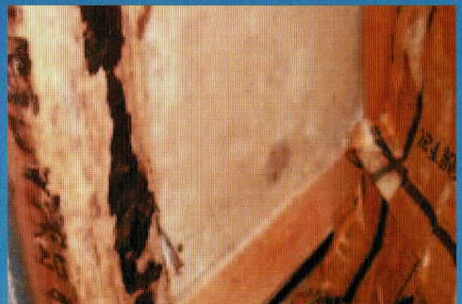
下地材が腐朽している。
